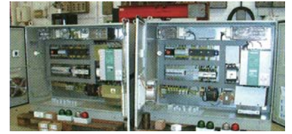
Maco EP 永電磁リフター用制御盤 ON-OFF 時の電源供給は 1-3 秒のみ
